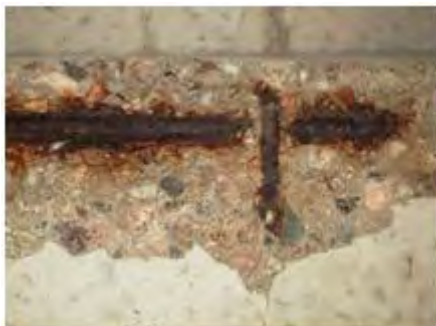
Exempel på skadad balkong. OBS! Annat objekt!
