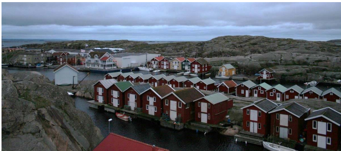
Bodarna på Lännudden och det magasin som omkring 1930 byggdes om till rökeri.
