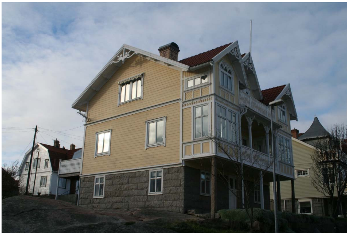
Sekelskiftesvilla på hög grund av huggen sten, snickarglädje, balkonger och verandor.
