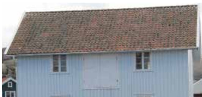
Bildexempel på ett helt orört tak med gammalt tegel som har tydlig originalkaraktär.
