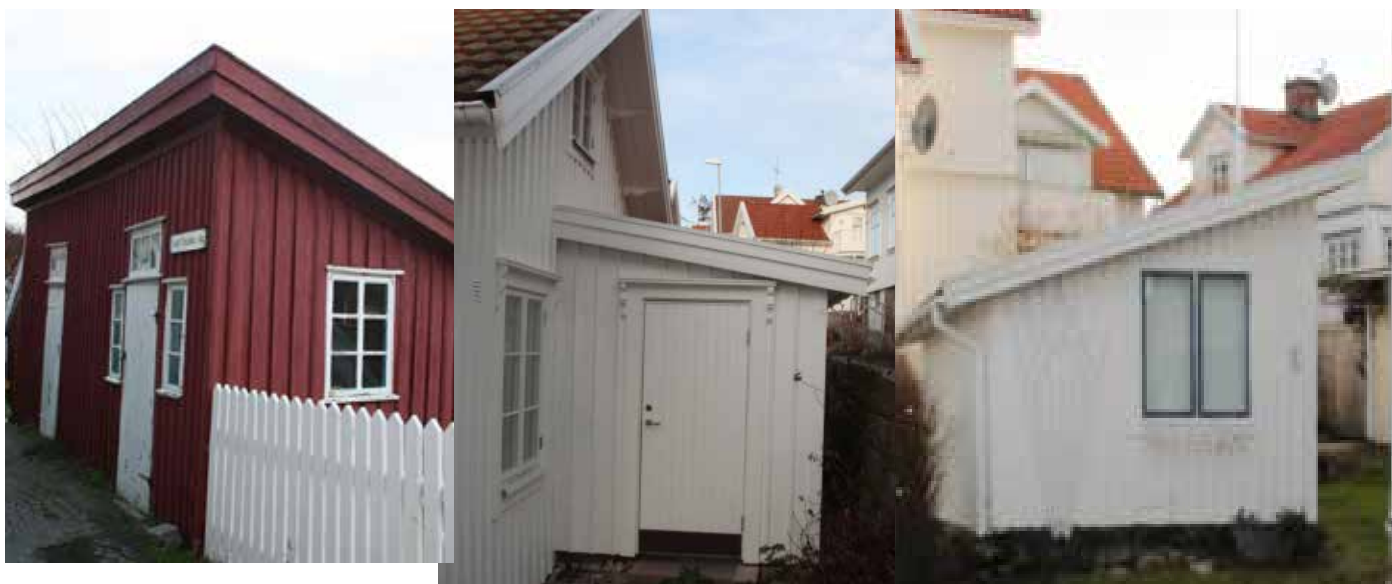
Tillbyggnader och komplementbyggnader som är varsamt anpassade till miljön och byggnaden
