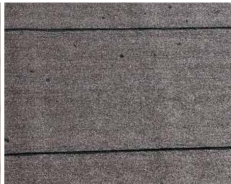
Tjärpapp, vanligt framförallt på komplementbyggnader
