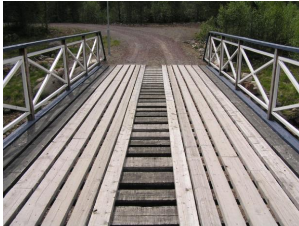
Befintlig vägbro in till området.
