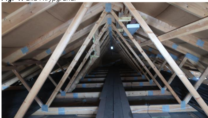
Fig. 2. Bild inockvind som visar undersidan av yttertaket bjälklag.
