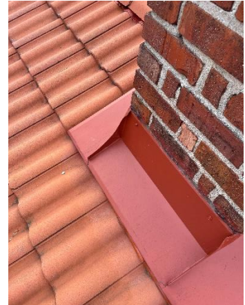
Plåtbeslagning runt skorstenar
