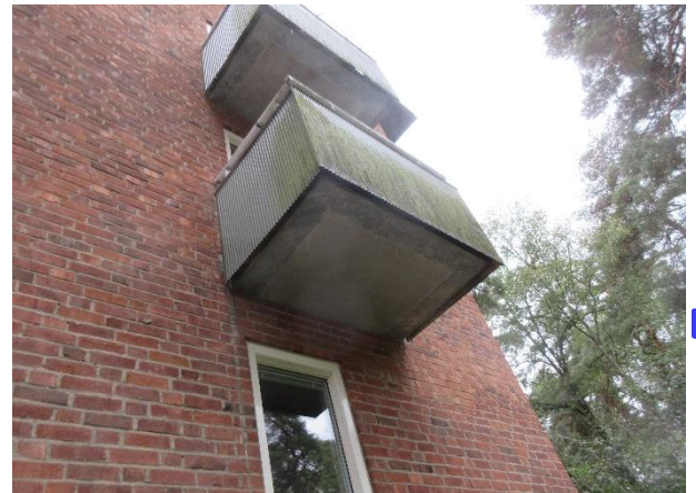
Balkongplattor i betong
