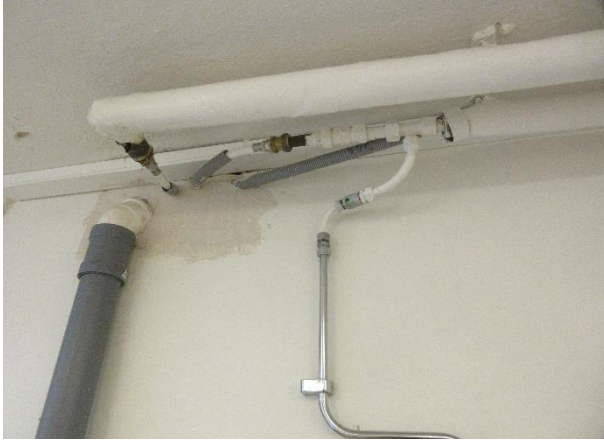
Delvis gamla galvaniserade kallvattenrör
