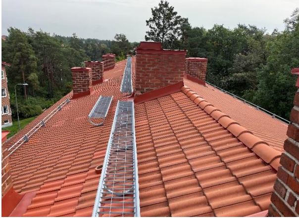
Yttertak med en del utbytta pannor
