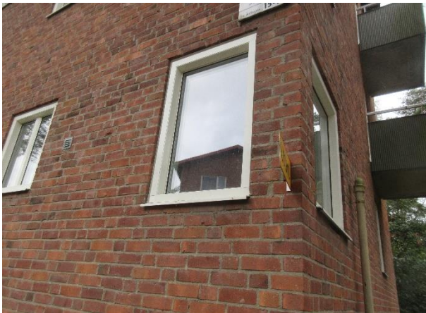
Nya fönster monterade
