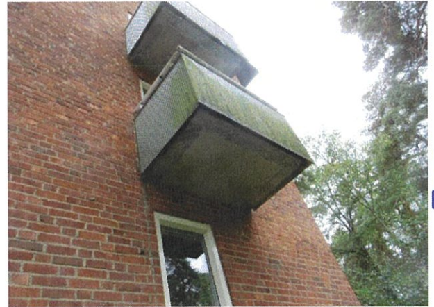
Balkongplattor i betong
