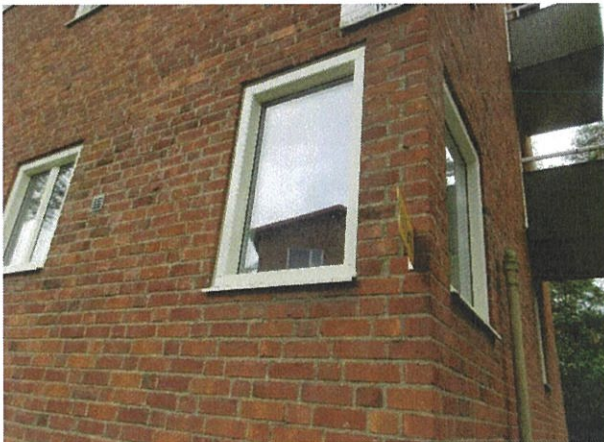
Nya fönster monterade
