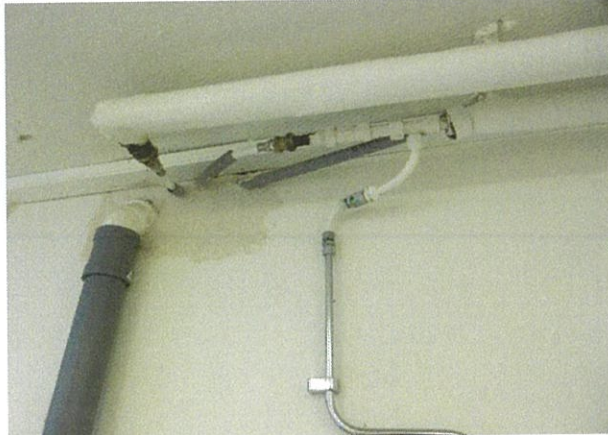
Delvis gamla galvaniserade kallvattenrör
