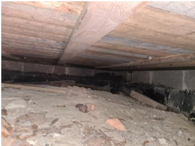
Krypgrund norra delen, översiktsbild via ventil.
