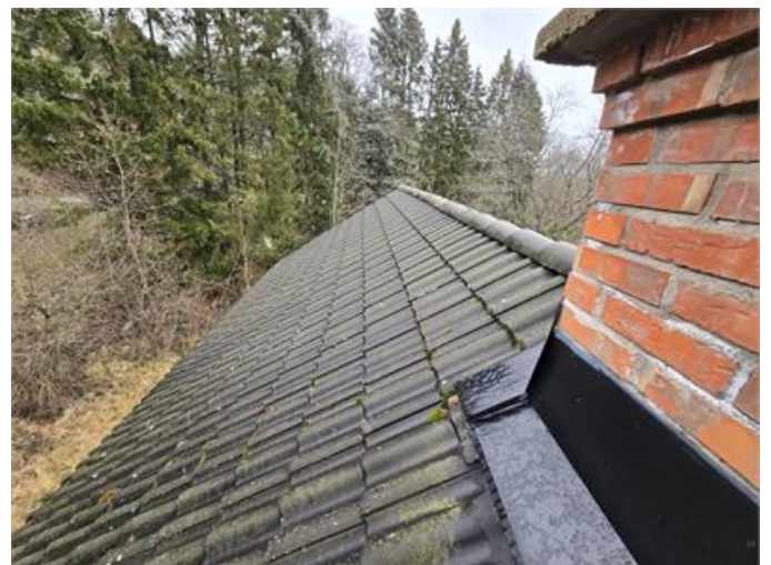
Översiktsbild av Tak.
