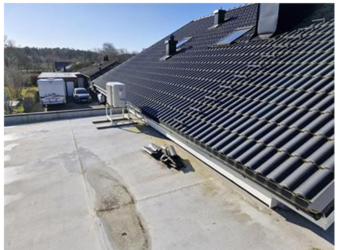
Tak, översiktsbild garage och bostad.
