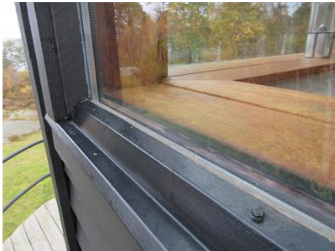
Isolerkassetter monterad i befintlig karm
