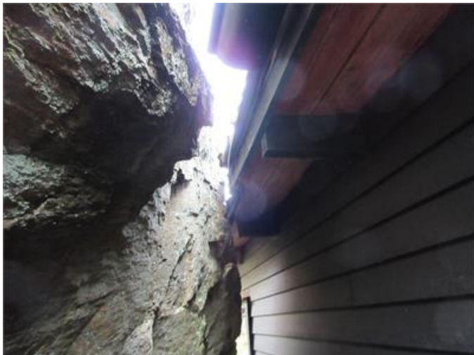
Berget i anslutning till fasad/tak
