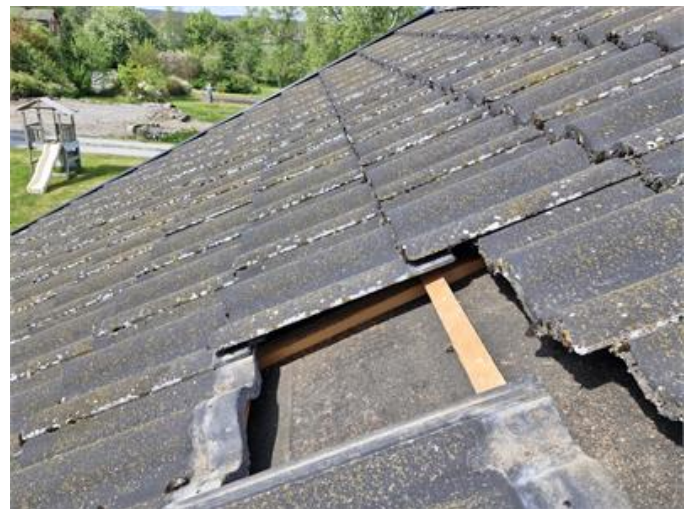
Tak, kontroll under pannor.
