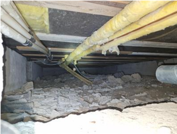
Krypgrund, översiktsbild södra delen.
