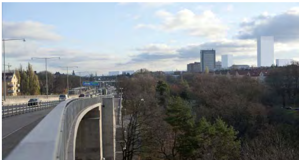
Vy från Tranebergsbron. Marieberg med bebyggelse begränsad av inflygningen till Bromma flygplats (max +130 m.ö.h.).
