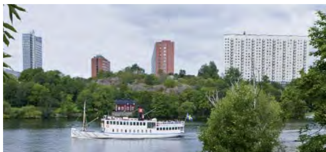
Befintliga byggnader i Marieberg. Från vänster DN-skrapan, SvD/Sweco-huset, ”baconhuset”, ”dragspelshuset” och nere vid vattnet Triewalds malmgård.
