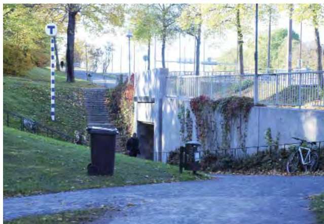
Entrén till Thorildsplans tunnelbanestation i Konradsbergsparken nedanför Drottningholmsvägen.
