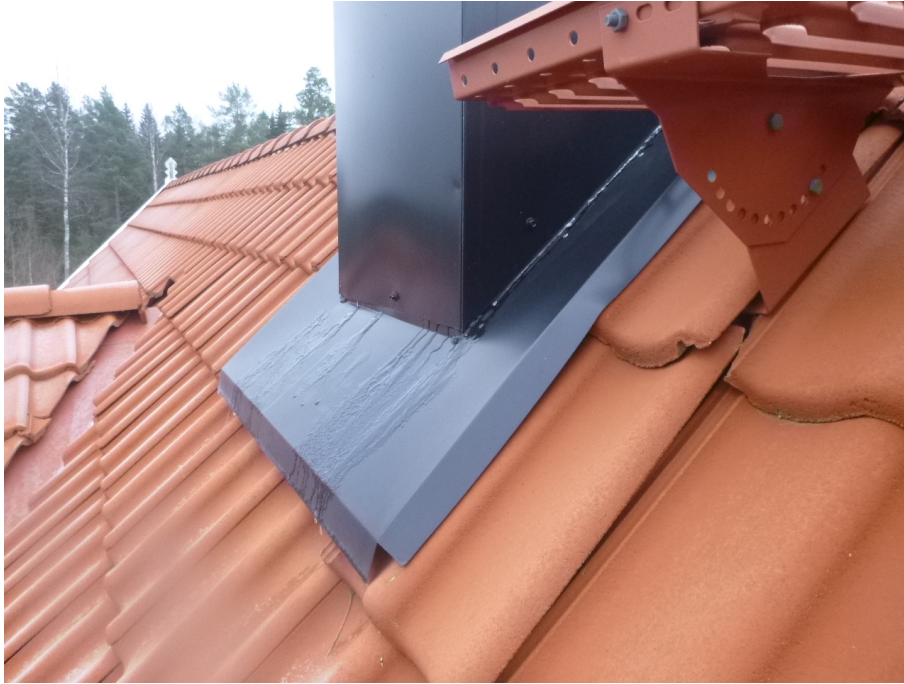
Plåtinklädnad skorsten/infästning takbrygga.
