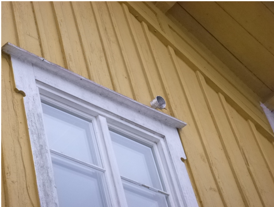
Genomföring köksventilation, övervåning.
