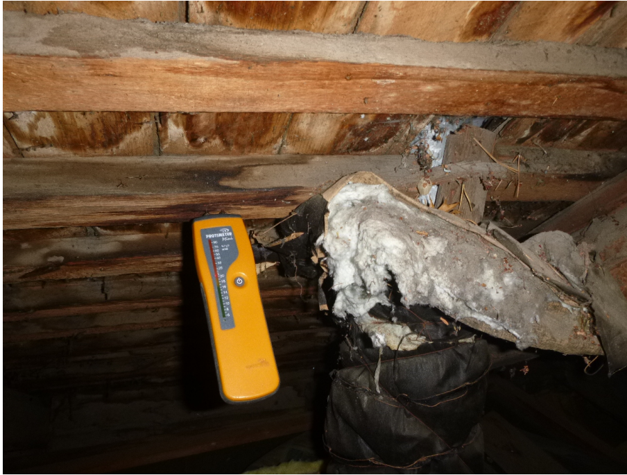
Undertak intill frånluftsgenomföring, bakre sidovind.
