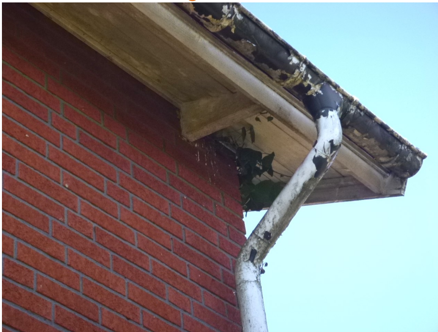
Hängrännor/stuprör mot baksida.
