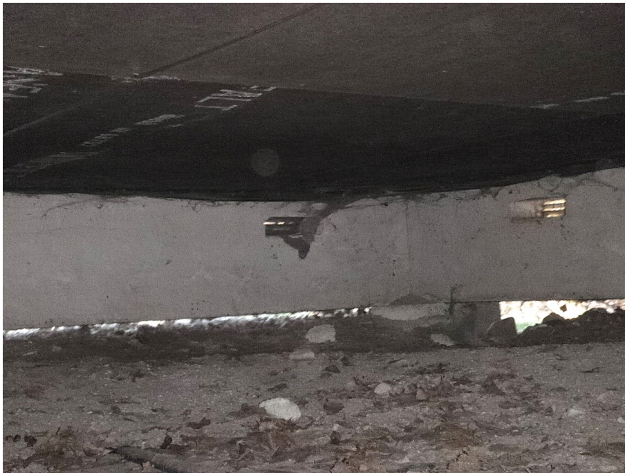
Krypgrund, hörn mot baksida.
