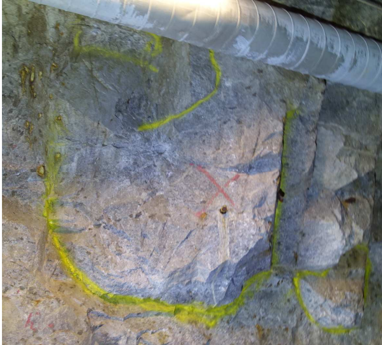
Figur 5 Fastbultat bomt block med mindre område med låghållfastberg ovanför.
