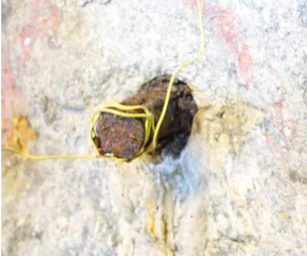
Figur 1 Foto på rostangripen bult.
