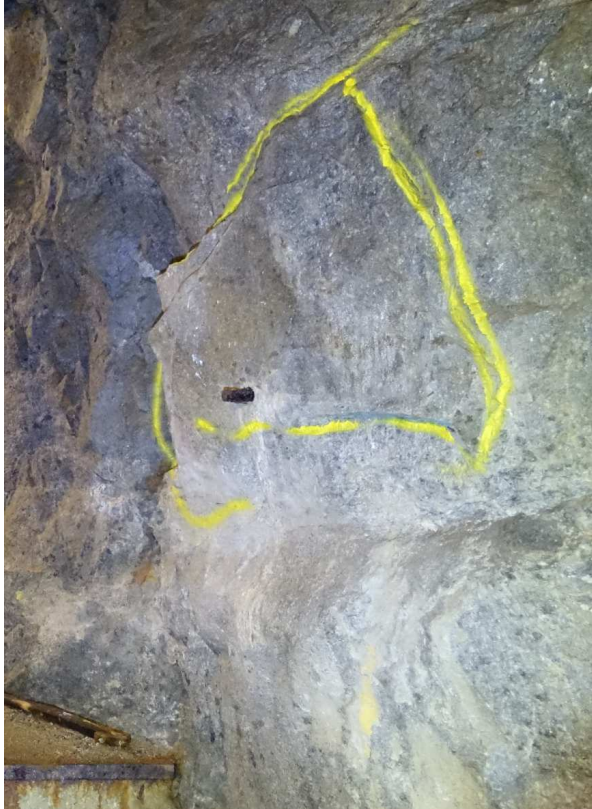
Figur 8 Område med bomt berg som är fastbultat.
