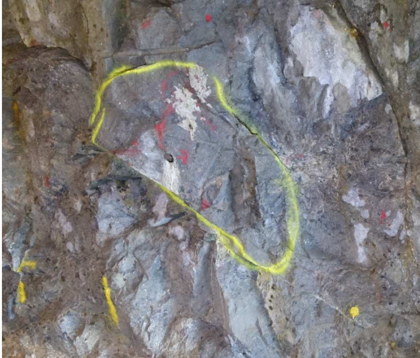
Figur 4 Område med bomt berg som är fastbultat.
