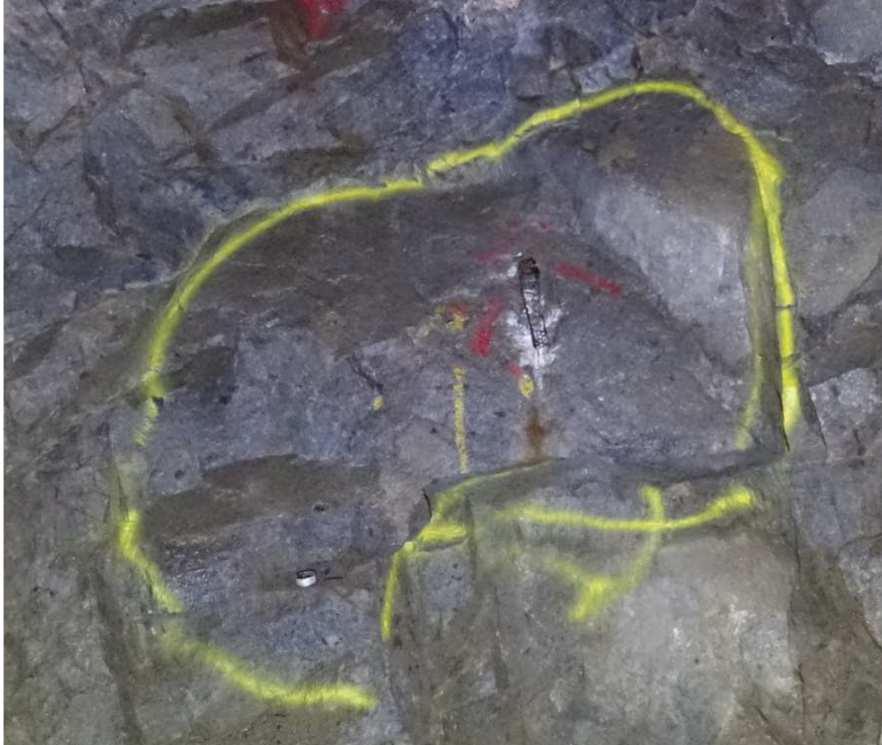
Figur 9 Område med bomt berg som är fastbultat.
