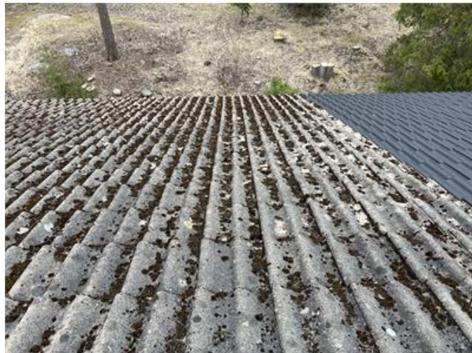
Bild på delar av taket.
