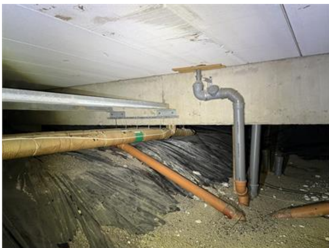
Bild från krypgrunden.
