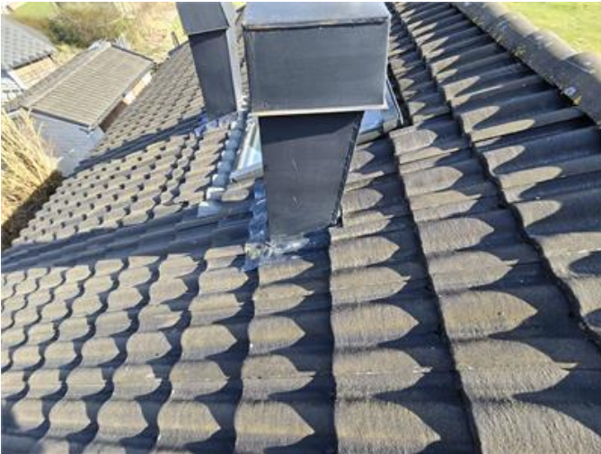
Tak: Översiktsbild, äldre takhuvar.
