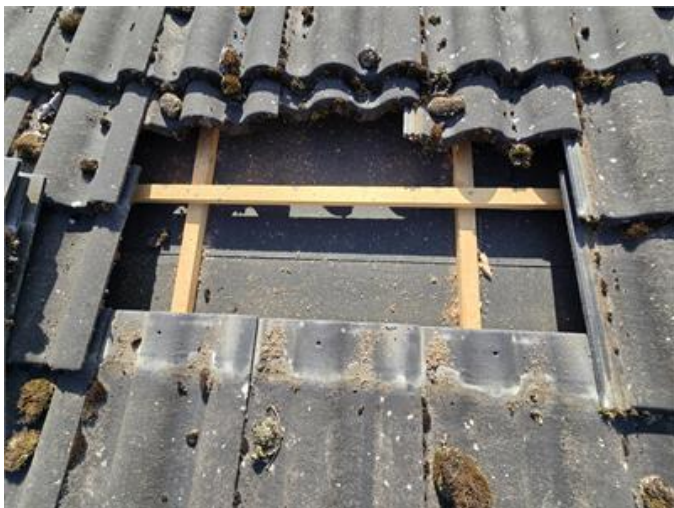
Tak: Stickprovskontroll under pannor.
