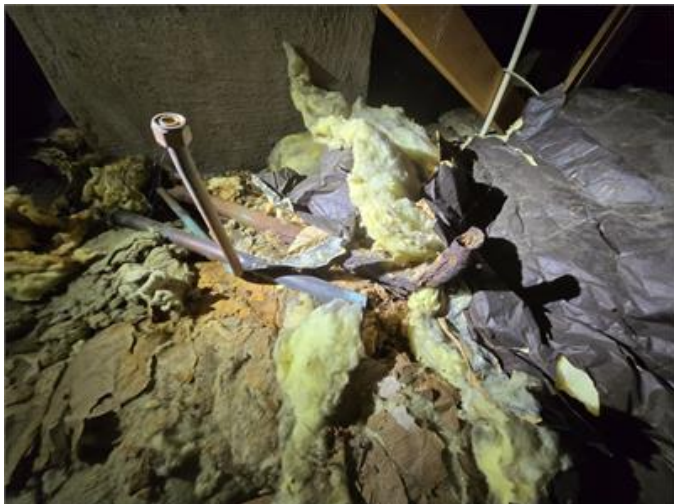
Nockvind: Delvis avrostade rör från tidigare expansionskärl.
