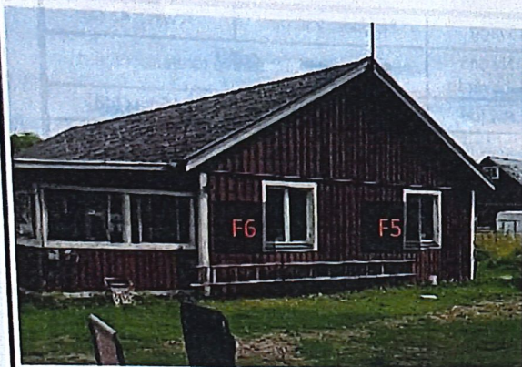
Fasad mot bullerkälla
