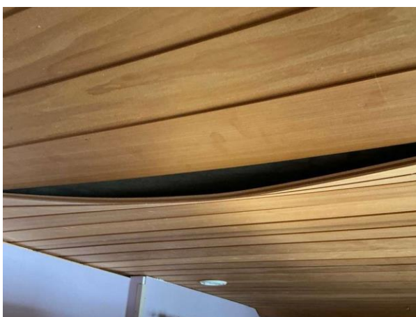
Bild 4: Invändigt, Entréplan, Sovrum 2, Innertaket har släppt
