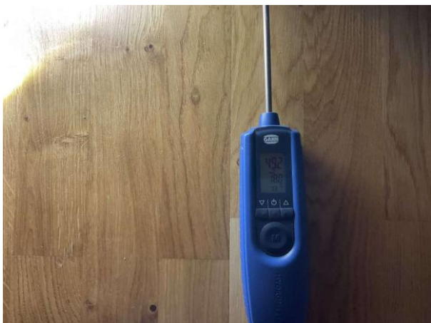
Bild 5: Invändigt, Källarplan, Sovrum 1, Fuktkontroll utförd under gränsvärde se bilaga 4
