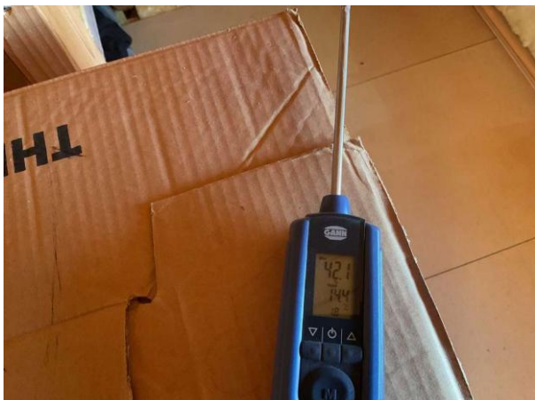
Bild 1: Utvändigt, Vind, Fuktkontroll utförd pånockvinden under gränsvärde se bilaga 4
