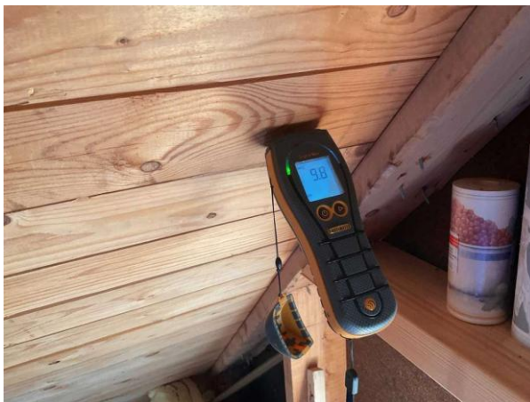
Bild 2: Utvändigt, Vind, besiktningen Fuktkontroll utförd pånockvinden under gränsvärde se bilaga 4
