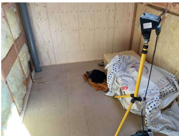
Bild 8: Invändigt, Övervåning, wc, renovering pågår ej besiktigat utrymmet
