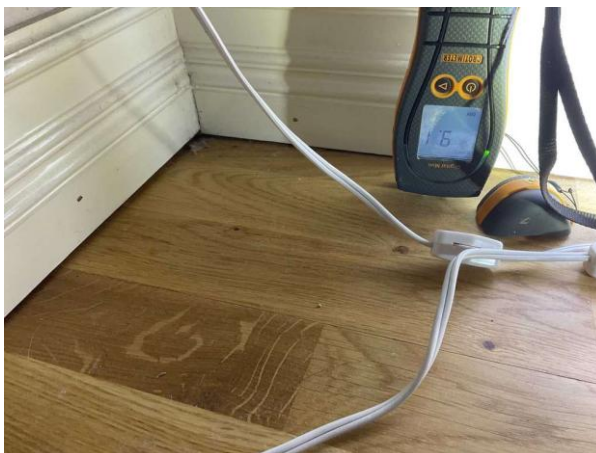
Bild 6: Invändigt, Källarplan, Sovrum 1, Fuktkontroll utförd under gränsvärde se bilaga 4
