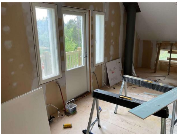
Bild 2: Invändigt, Övervåning, Sovrum 1, Under uppbyggnad.
