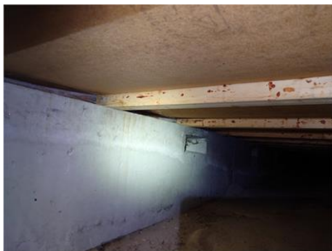
Rimfrost förekommer på syllar, blindbotten samt grundelementen
