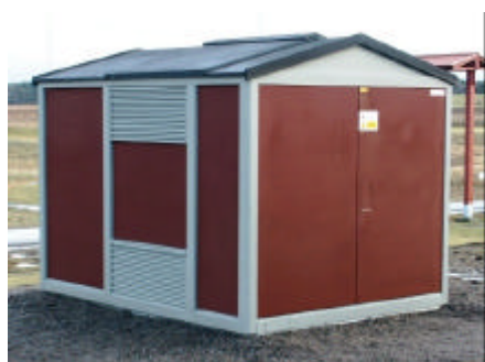
Exempel på utformning av nätstation.
