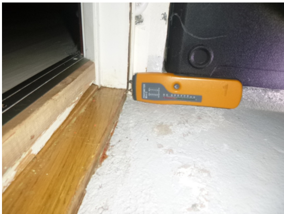
Fuktkvotsmätning i dörrkarm.
