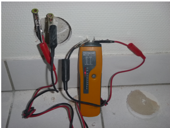
Fuktkvotsmätning, utreglad väggkonstruktion.
