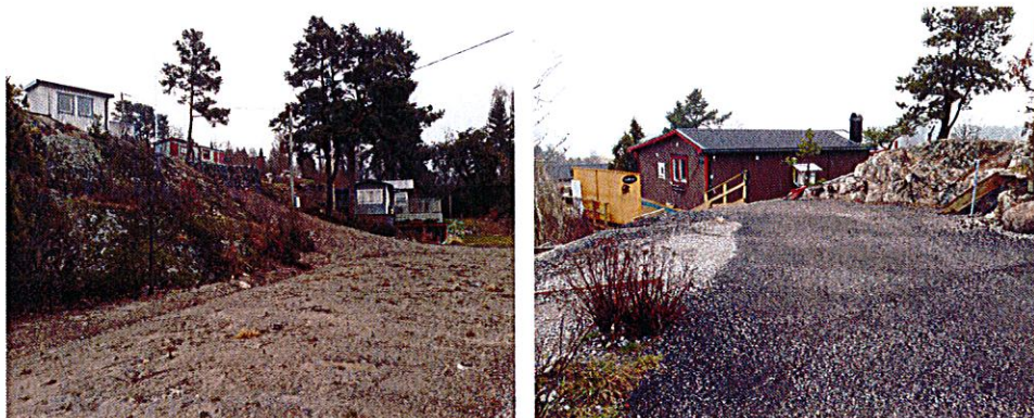
Figur 10. Befintlig bebyggelse. Foto: Sani Muric.
