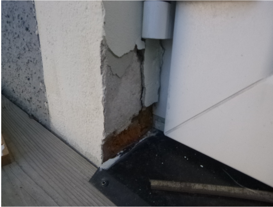
Putssläpp intill altandörr, souterängplan.
