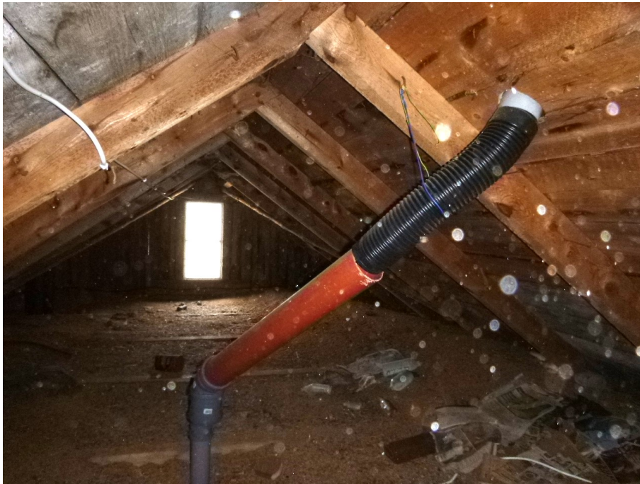
Avloppsavluftning vindsutrymme.
