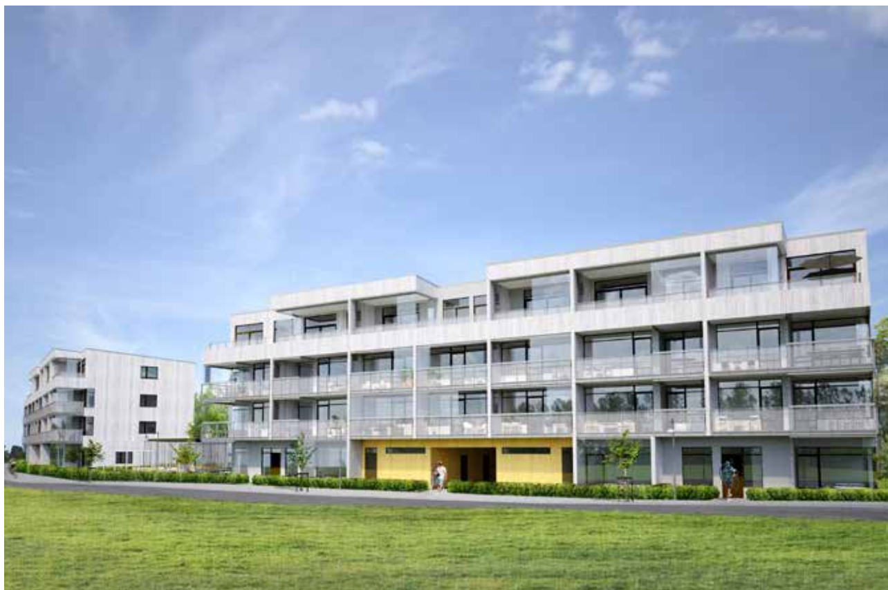
Vårbörken byggs med en stomme av betong. Delar av stommen kläs med värmebehandlad furupanel.
