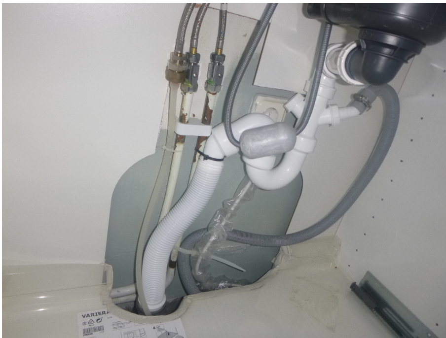
Otätthet intill genomföringar, diskbänksskåp.
