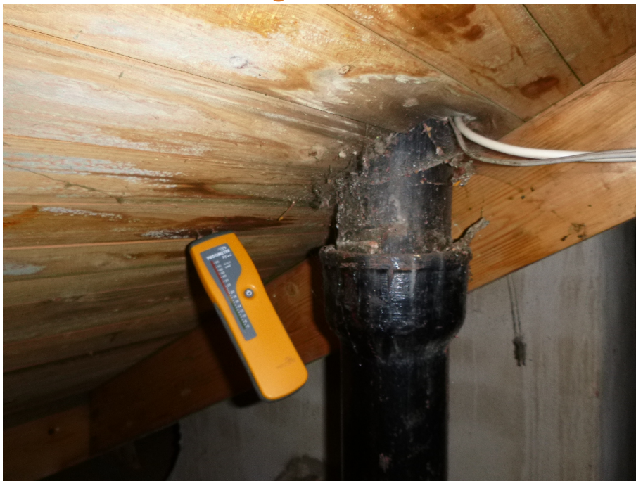
Undertak intill avloppsavluftning, vindsutrymme.
