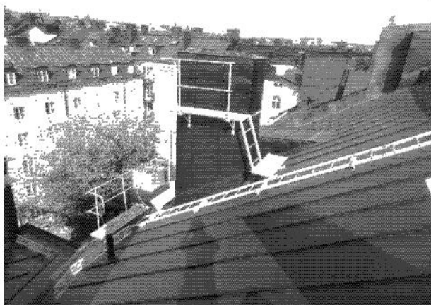
Yttertak med takskydd
