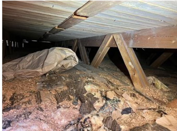
Bild på övrig del av vinden från vindsluckan.
