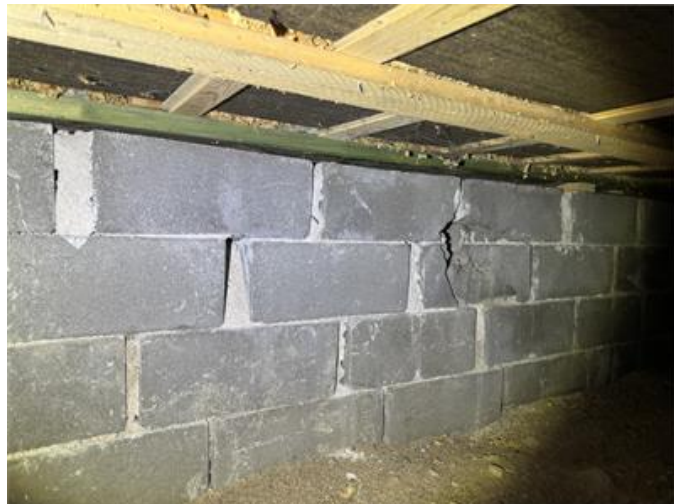
Träskyddsbehandlad syll i krypgrunden.
