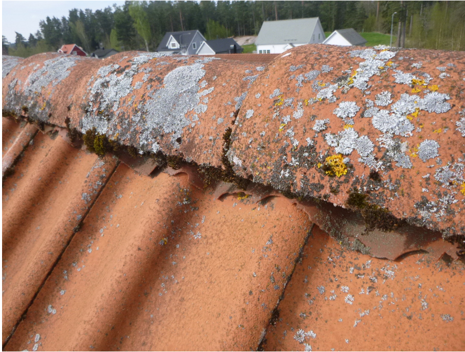
Nocktätning spröd/sprucken.
