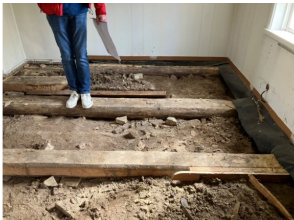
Bild 1 – Start av rivning bottenbjälklag
