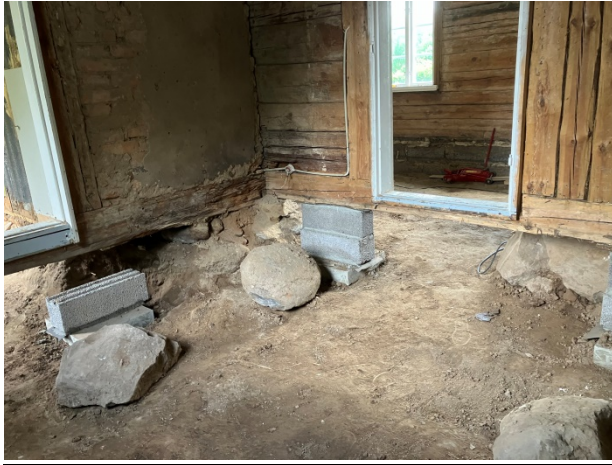
Bild 14 visar ny förstärkning – uppallning av bärande timmerväggars- stockar. Nya gjutna Btg-fundament med uppallning av Lecablock
