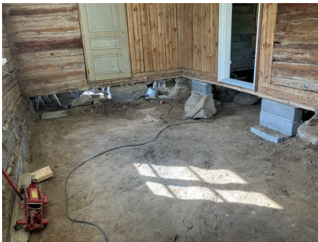
Bild 15 visar ny förstärkning – uppallning av bärande timmerväggars- stockar. Nya gjutna Btg-fundament med uppallning av Lecablock
