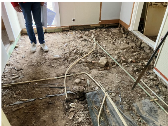
Bild 3 – Start av rivning bottenbjälklag
