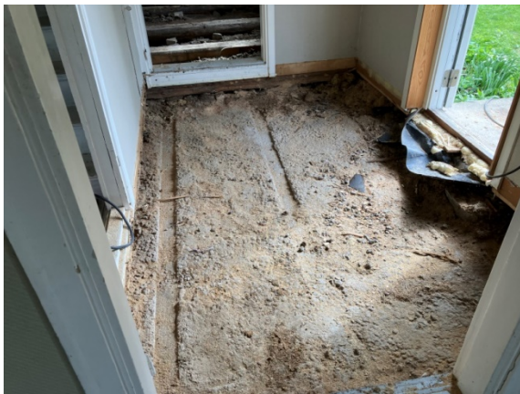
Bild 4 – Start av rivning bottenbjälklag – visar del av Btg-platta Entré
