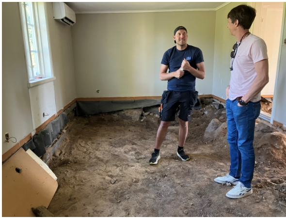
Bild 6 utgrävning-schakt inför Btg-platta
