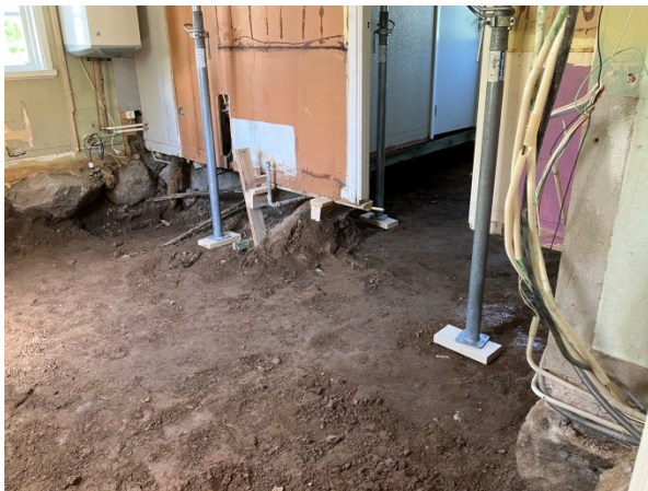
Bild 10 utgrävning-schakt inför Btg-platta samt säkerhetsstämp för bärande väggar – stämp i delar av byggnaden för att säkra mot sättningar av timmerstommen och vindsbjälkaget
