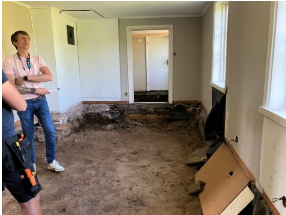
Bild 5 utgrävning-schakt inför Btg-platta
