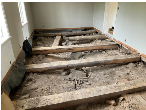
Bild 2 – Start av rivning bottenbjälklag
