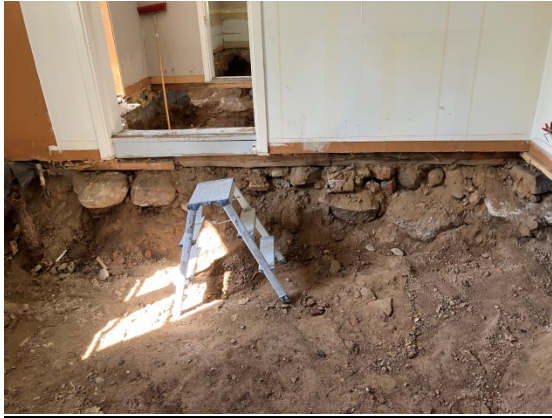
Bild 9 utgrävning-schakt inför Btg-platta
