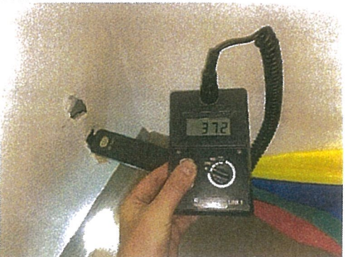
Normala fuktindikationer uppmättes på badrumsvägg från klädklädkammaren.
