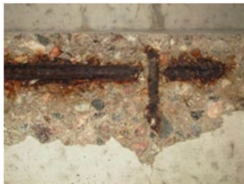
Exempel på skadad balkong. OBS! Annat objekt!
