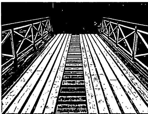
Befintlig vägbro in till området.
